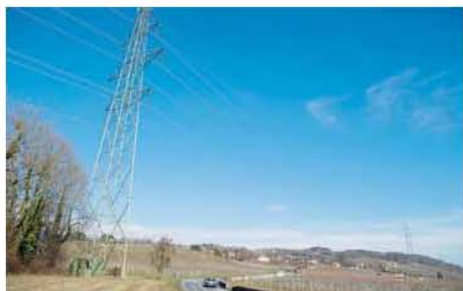
L'antenne installée sur ce pylône du bus du village, arrose surtout la route et l'est du village. Cela devrait changer. SIFFREDO HARO
